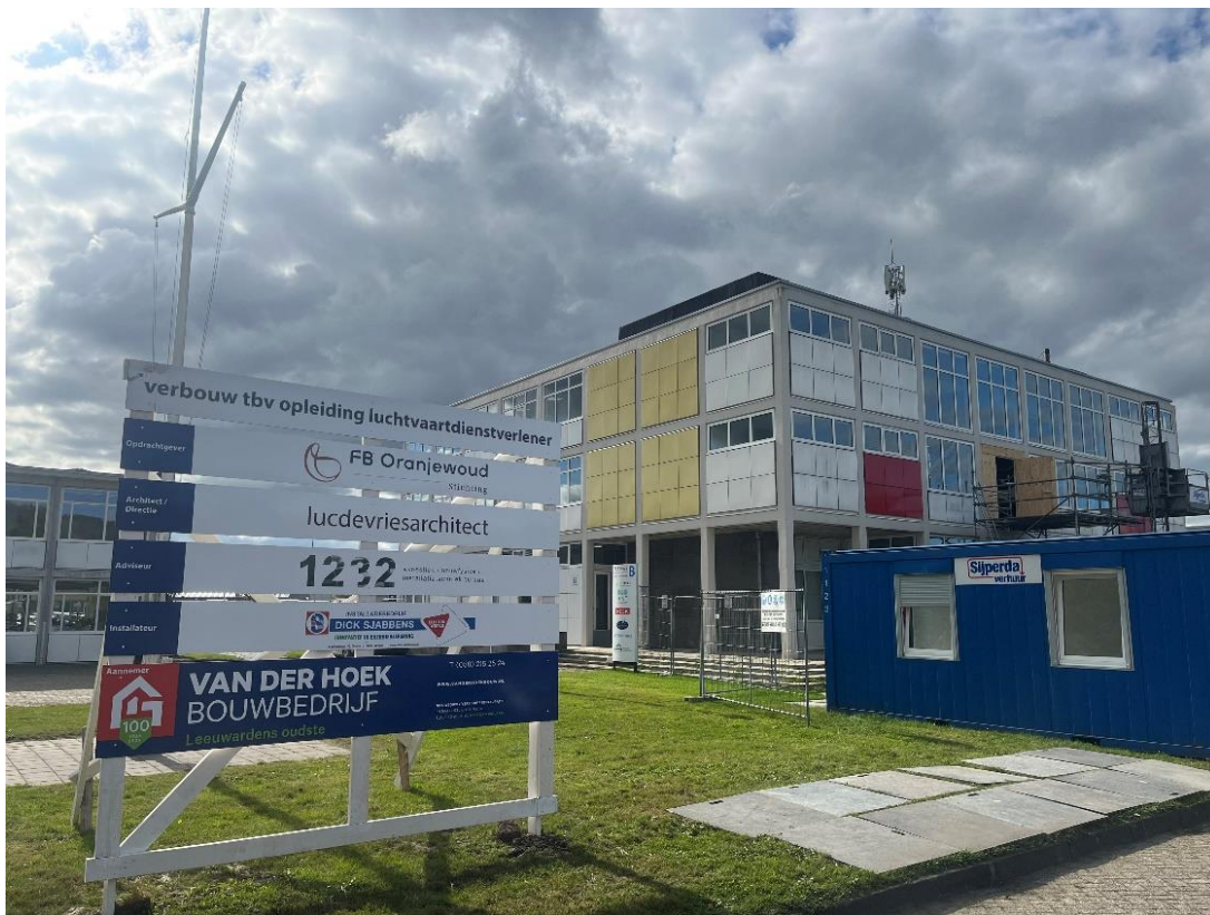
In 2024 vond verbouwing plaats van de voormalige Rijksluchtvaartschool ten behoeve van de opleiding Luchtvaartdienstverlening van Noorderpoort
